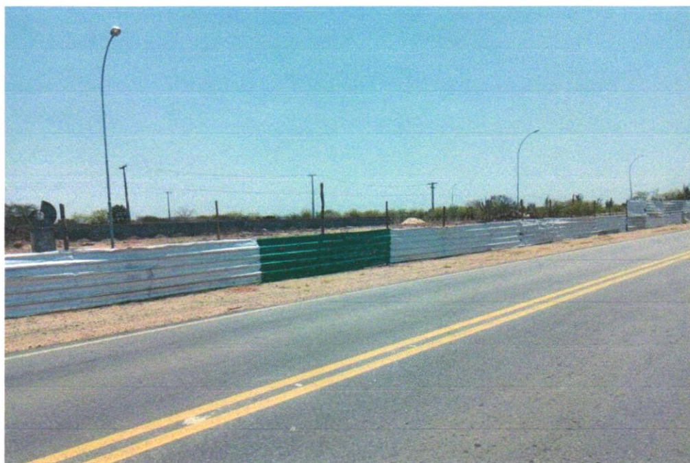
Foto 01 - TAPUME COM TELHA METÁLICA. AF_05/2018
