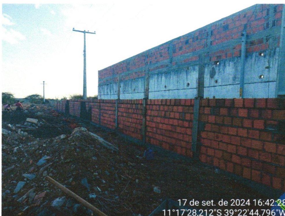
Foto 10 - ALVENARIA DE VEDAÇÃO DE BLOCOS CERÂMICOS FURADOS NA VERTICAL DE 9X19X39 CM (ESPESSURA 9 CM) E ARGAMASSA DE ASSENTAMENTO COM PREPARO EM BETONEIRA. AF_12/2021
