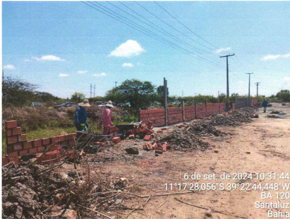
Foto 11 - ALVENARIA DE VEDAÇÃO DE BLOCOS CERÂMICOS FURADOS NA VERTICAL DE 9X19X39 CM (ESPESSURA 9 CM) E ARGAMASSA DE ASSENTAMENTO COM PREPARO EM BETONEIRA. AF_12/20212021
