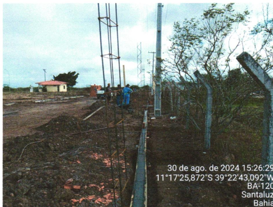
Foto 14 - (COMPOSIÇÃO REPRESENTATIVA) EXECUÇÃO DE ESTRUTURAS DE CONCRETO ARMADO, PARA EDIFICAÇÃO INSTITUCIONAL TÉRREA, FCK = 25 MPA. AF_01/2017
